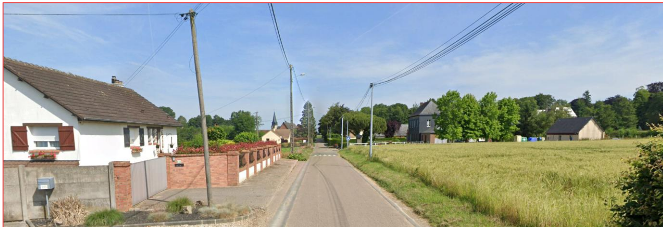
Secteur de jonction, route du bourg, incluant le futur espace l'espace de tri sélectif (source Google Street View)
